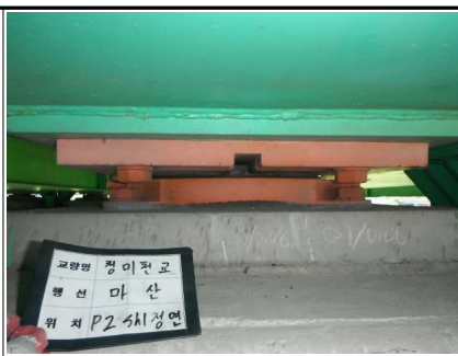
교량받침 전경 (P2-Sh1, 일방향)
