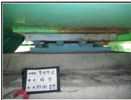
교량받침 전경 (P3-Sh1, 고정단)
