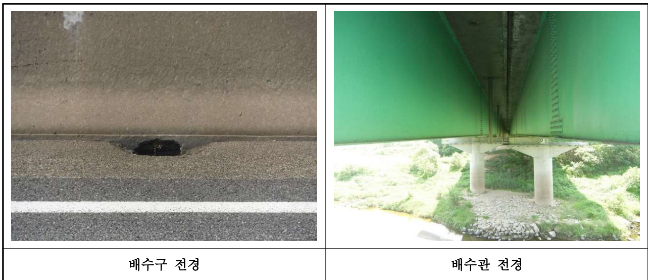
【그림 3-6】 배수시설 현황(양평방향)
