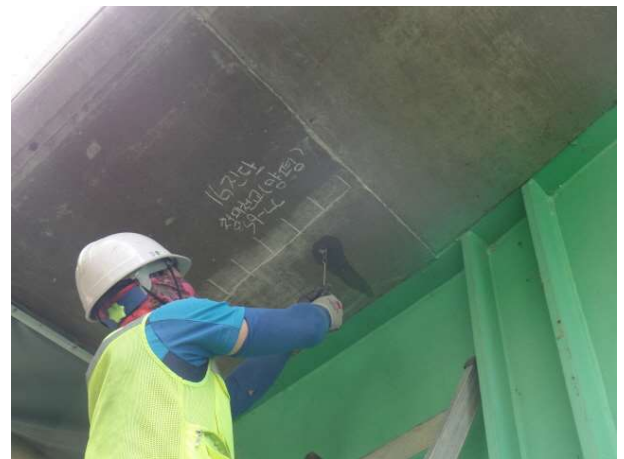
탄산화 깊이 측정
