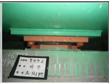
교량받침 전경 (A1-Sh3, 양방향)
